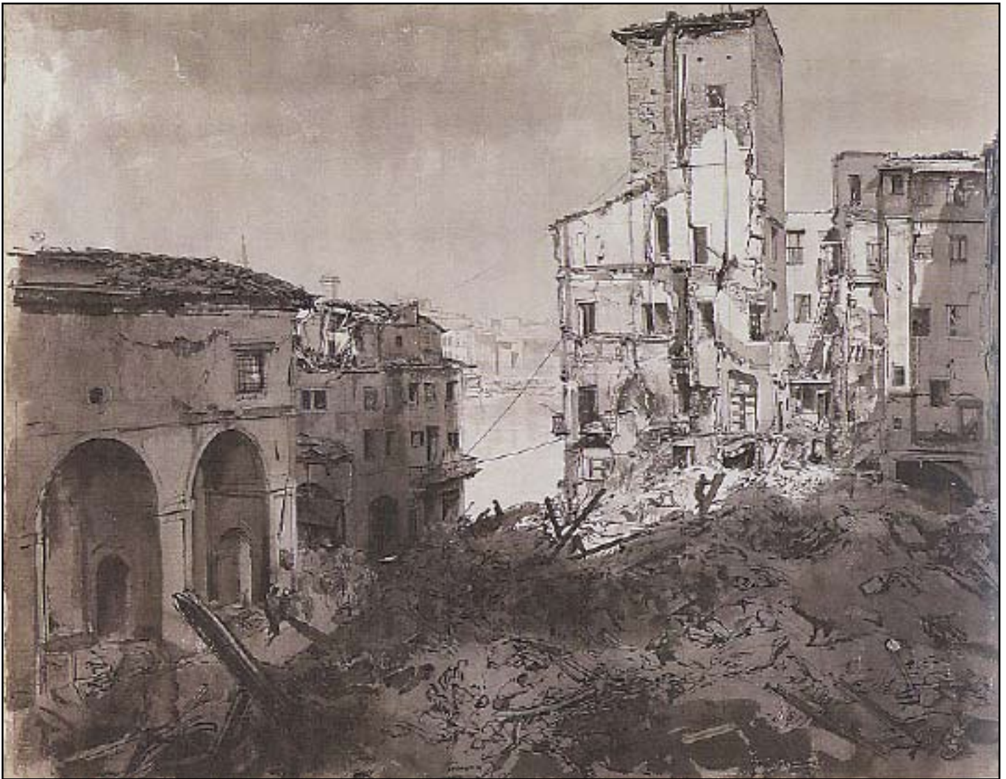
Above: Annigoni, Distruzioni di Firenze, Torre del Leone (dalla Canonica di S. Stefano) , 1944 Below: Demolished Chapel, Brownson Memorial Presbyterian Church, February 2009
